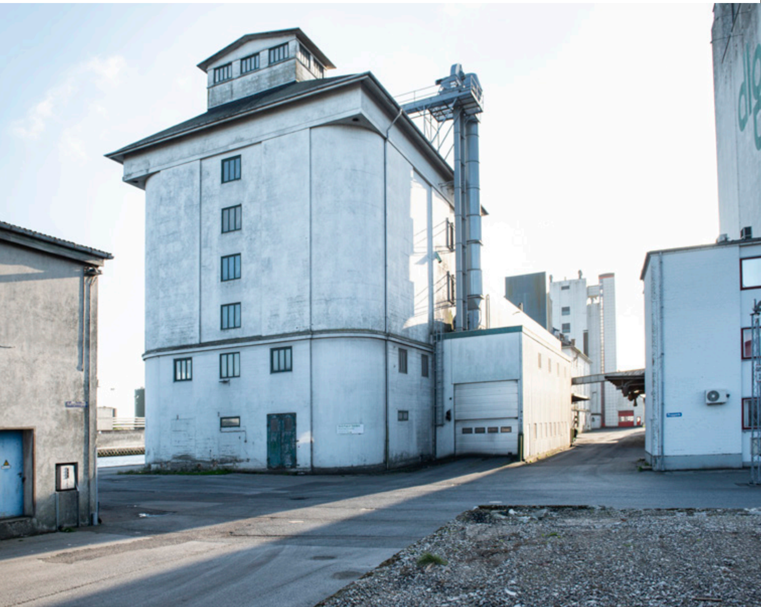
46 Randers Korn- og Foderstof Kompagni opførte i 1935 et silo- og kajpakhus i jernbeton på Kongensgade 8. Bygningen er karakteristisk ved sine runde hjørner og sit elevatorhus, 2025. Foto: Mark Cowper Dyer, Museum Østjylland.
