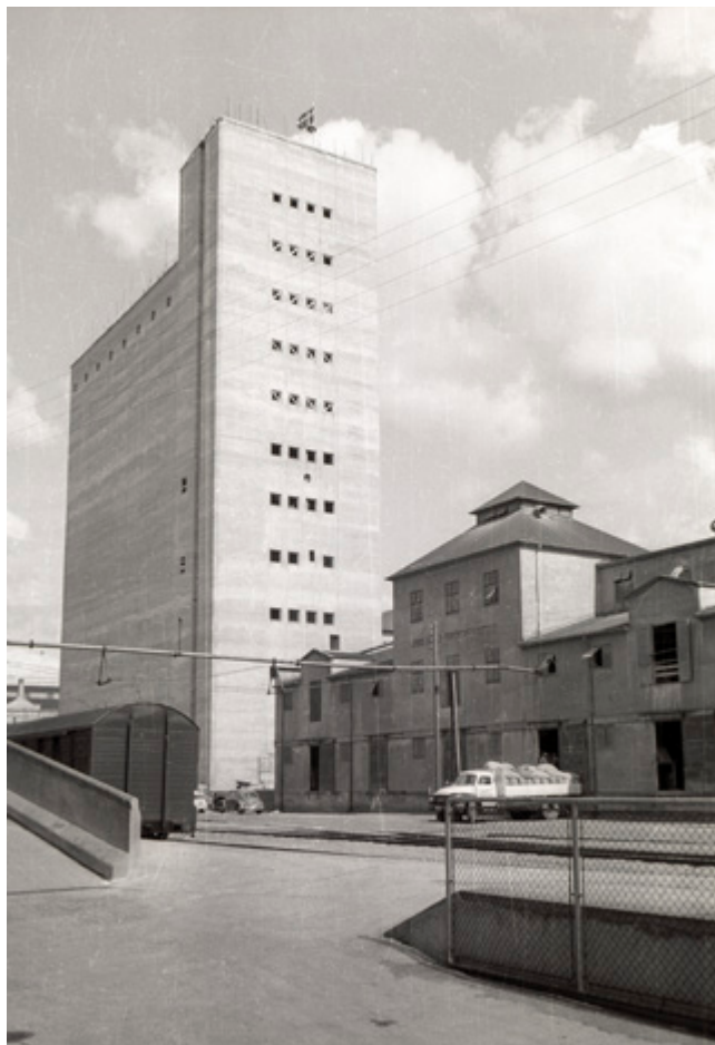
Rejsegilde i 1961 på silo hos Randers Korn- og Foderstof Forretning på Kongensgade 6. Anlægget, der stod færdigt i 1964, er ti etager højt og opført i funktionalistisk stil. I 2002 overgik det til DLG, Dansk Landbrugs Grovareselskab. Foto: Randers Stadsarkiv.
