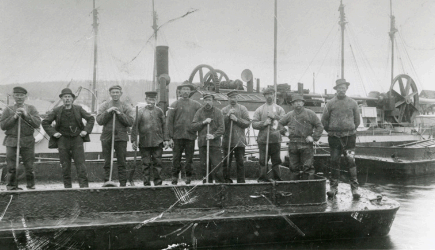
Arbejdet var slidsomt på de dampdrevne mudderpramme, der hjalp med opmudring af fjorden og havnen for at forbedre besejlingsmulighederne, 1905-1915. Foto: Randers Stadsarkiv.
