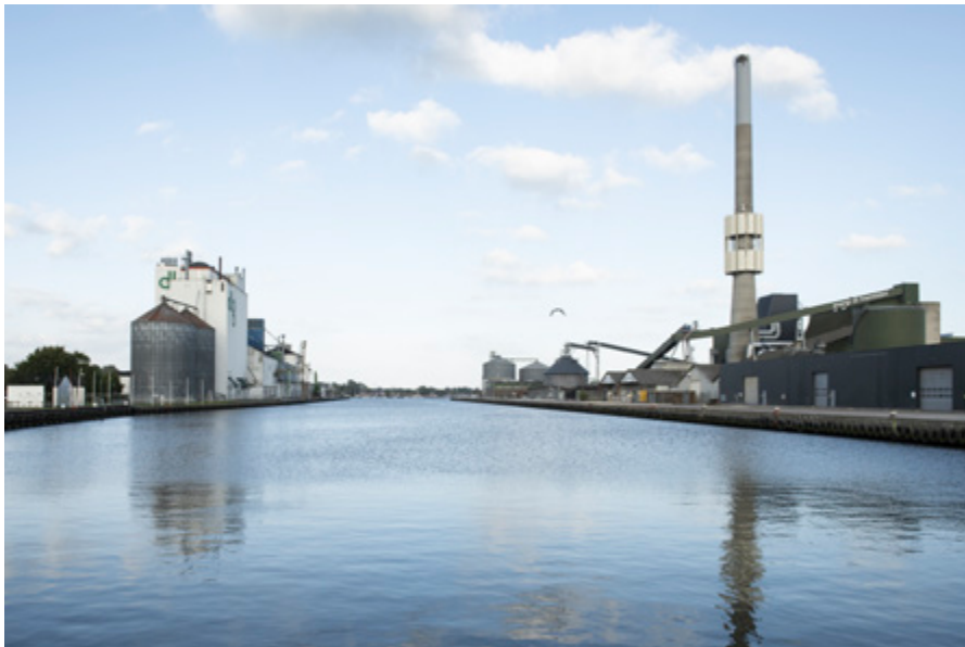
Tårnsiloer og pakhuse af jernbeton med elevatorstårne og fordelingslofter rejser sig højt mod himlen på Kongensgade, 2025. Foto: Mark Cowper Dyer, Museum Østjylland.
