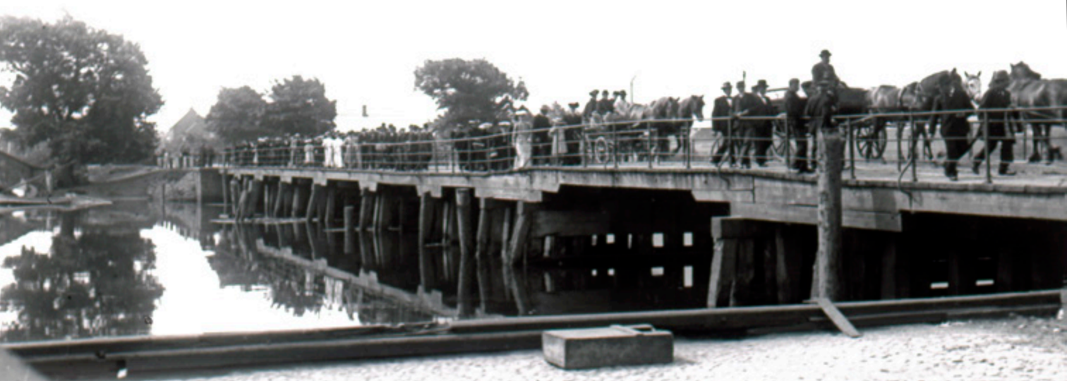
En bro af jern erstattede i 1865 den sydlige del af broen, mens den nordlige frem til 1905 fortsat var opført i træ. Først i 1906-1908 blev træbroen udskiftet med en af de første broer af jernbeton i Danmark. Foto: Randers Stadsarkiv.
